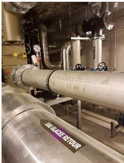
Le même réseau primaire, qui s'étend du Centre de Valorisation Énergétique aux sous-stations, distribue de la chaleur. En hiver, il est utilisé pour le chauffage de bureaux et logements, et en été pour la climatisation de locaux. Ainsi, l'excédent d'énergie thermique produit par la combustion des déchets en été n'est plus perdu mais valorisé en froid.
